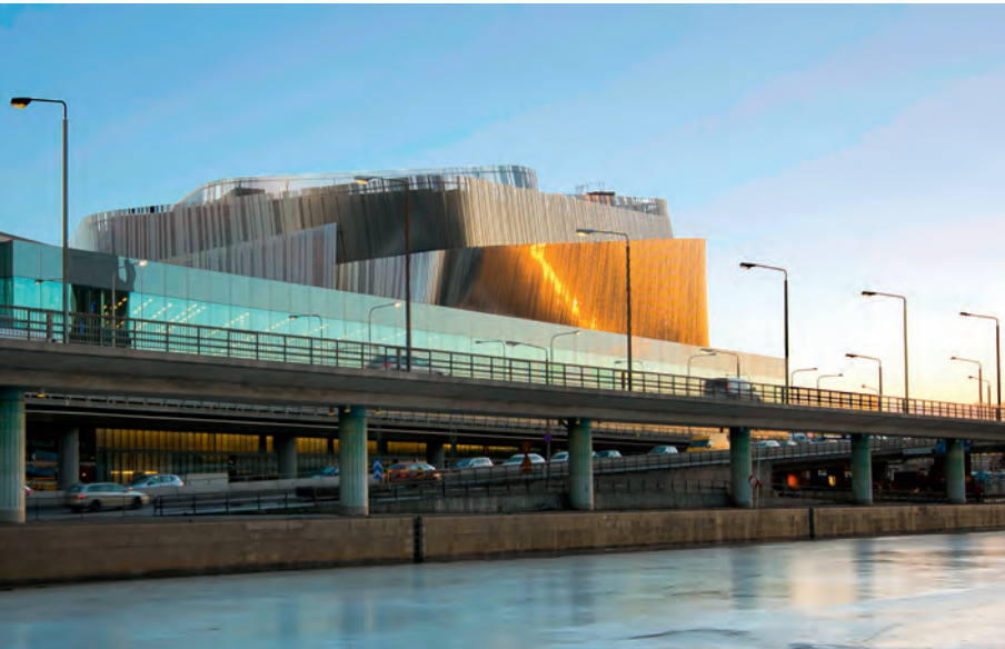
Het congrescentrum met zijn gevel van roestvast staal lamellen verheft zich majestueus boven de weg, het spoor en het water.
